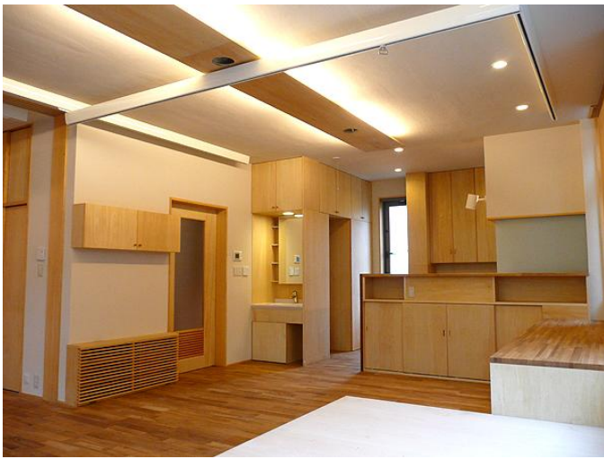
a. 居間 リフトのレールと間接照明を並行して走らせ、レールがインテリアに溶け込むように工夫している。
