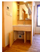
f. 洗面台 介護者の衛生保持のため、使用頻度の高い洗面台を居間に設けている。入室時にスムーズに使用できるように、入り口近傍に設置。
