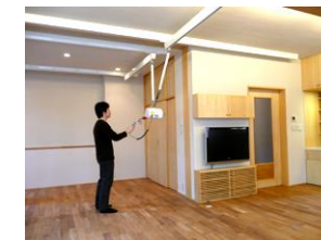
h. 介護リフト レールがあるマスの範囲は縦横に動け、移乗時にレールがついてくるので微調整しやすいXYレール式のものを選択した。
