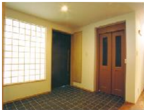
e. 玄関 玄関内での車椅子の移乗が可能となるように、内外2台分が置ける大きさを確保している。エレベーターは、将来的に体の硬直等でストレッチャーを使用することも想定し、現時点で奥行最大のものを選んでいる。
