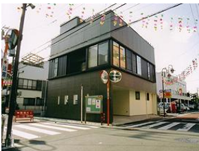
d. アプローチ 道路高さから1階の床高さまでスロープで擦り付け、車と人が同じアプローチを共有して広く使えるようにしている。
